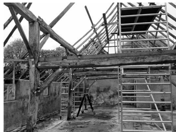
Tijdens de demontage van een dwarsdeelschuur in Heeswijk
