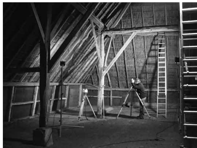
Het opmeten van een schuur in Hulten vóór de demontage
