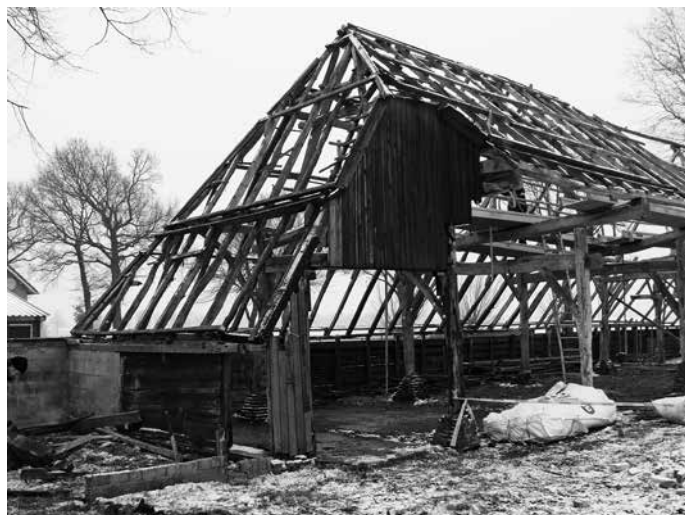
Demontage schuur in Wanroij tbv herbouw in Ledeacker
