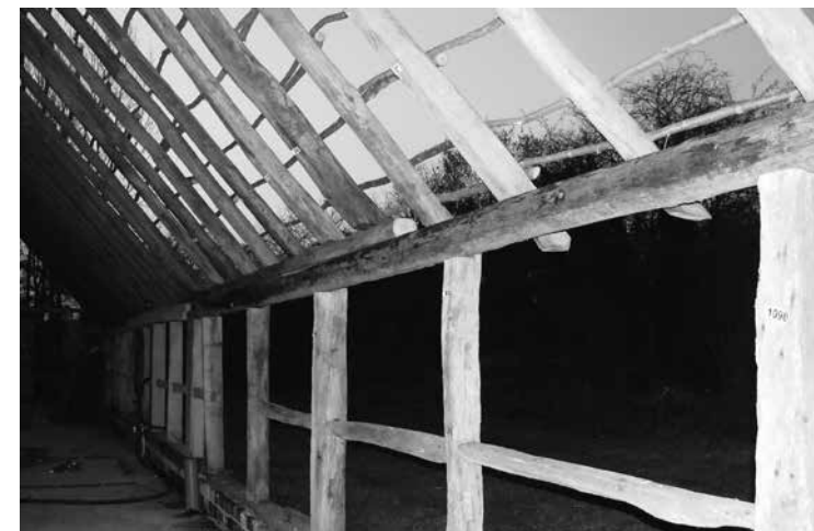
Hermontage van een authentieke vakwerkwand in Olland
