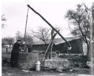
Waterput Steenbeek, ongeveer 1900. Ruben Loeffler. Best: Traditioneel Bouwen in de Oude Tijd, een handleiding voor landbouwkundigen en houthakkers in Noord-Nederland
