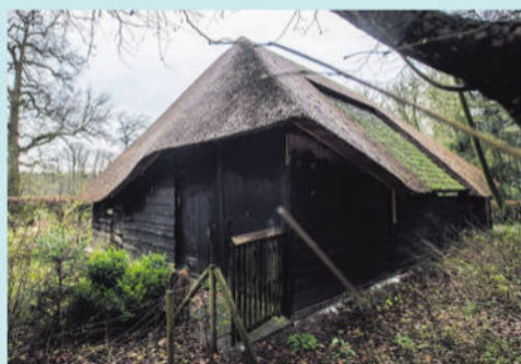
• De kenmerkende opstaande hoek aan beide zijden maakte het mogelijk dat een hoge kar kon doorrijden.
