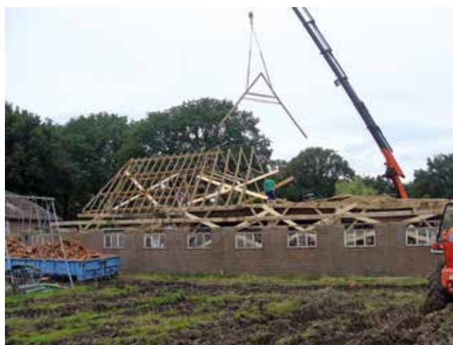
De sporenkap van de schuur in Vlierden vóór en tijdens de demontage. (foto's Pedro Schamp)
